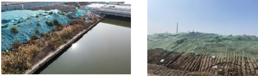
图 4.3-3 相关临时措施现场照片
