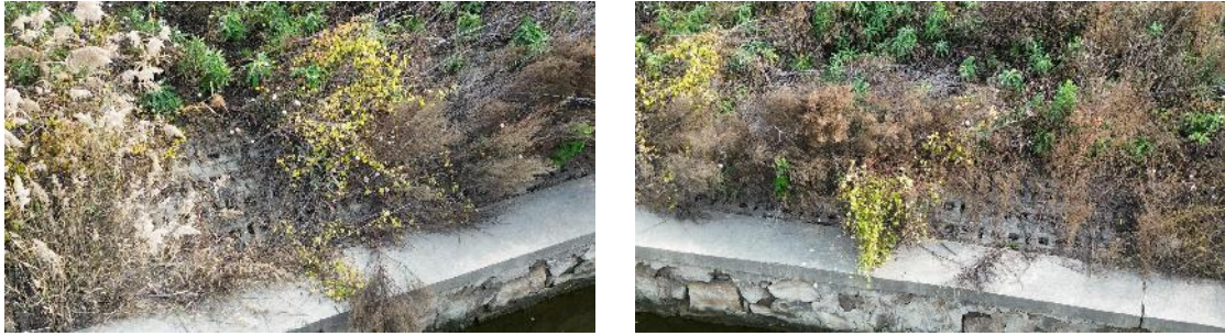
图 4.3-1 相关工程措施现场照片
