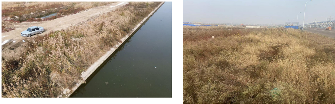
图 4.3-2 相关植物措施现场照片
