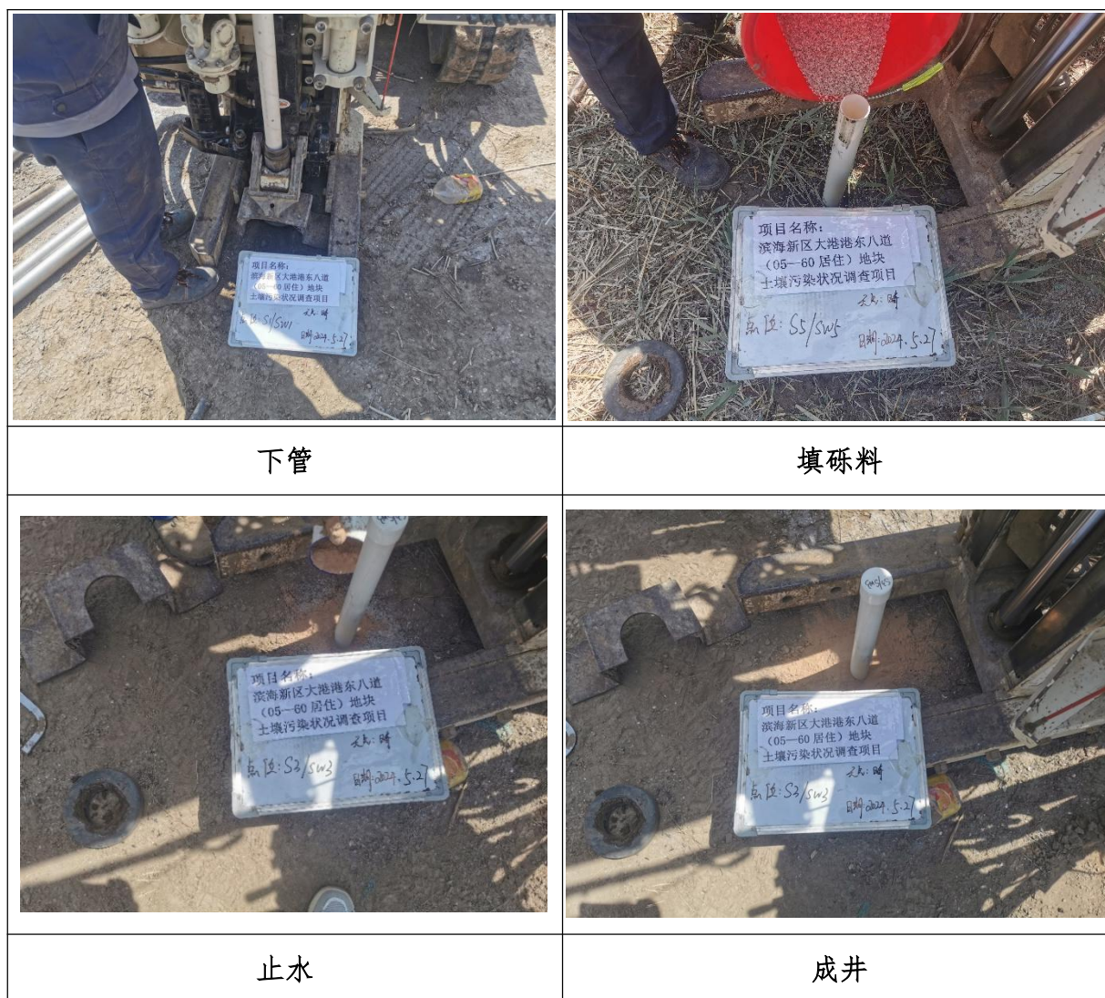
图 4-4 地下水监测井建井
