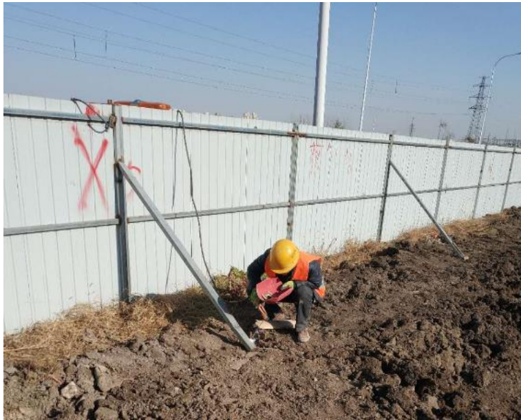
图 4-9 施工扬尘防治措施照片
