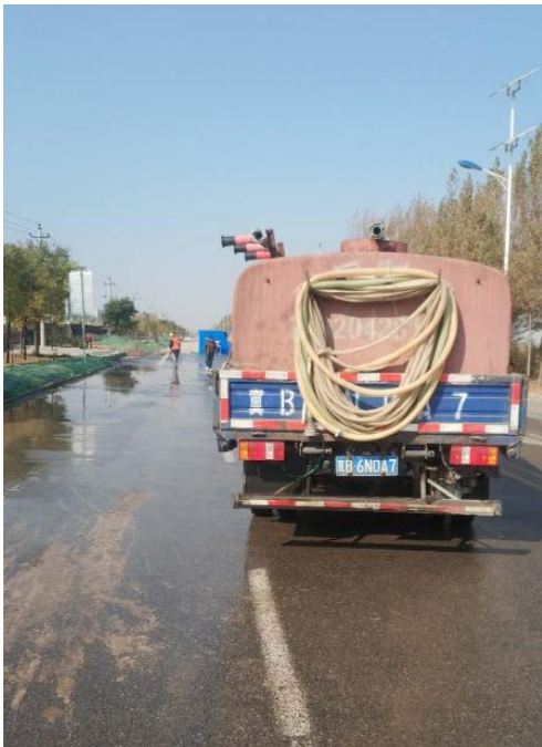
图 8-3 施工单位防尘洒水作业现场
