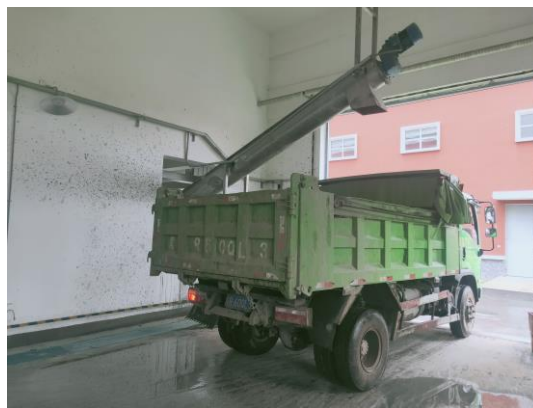
污泥暂存间内部
